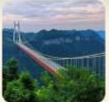
สะพานอ้ายจ้าย
