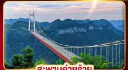
สะพานอ้ายจ้าย
